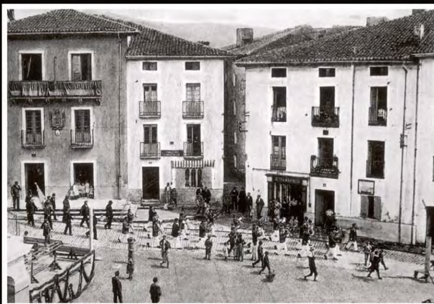
18- Udaletxea , Bonifazionekoa eta Urruzunoneko etxea, Goiko plazan .
